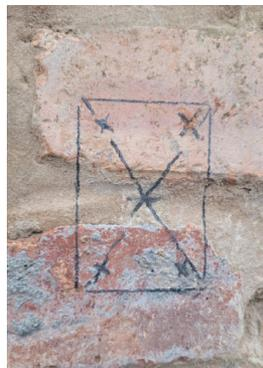
Je nach Beschaffenheit des Anbringungsortes können handelsübliche Mauerwerkdübel und Schrauben oder eine andere Alternative verwendet werden (nicht im Lieferumfang enthalten). Um die Halterung anzubringen, sobald alle Löcher gebohrt sind, schlagen Sie die Spreizschrauben mit einem Hammer in die Löcher.
