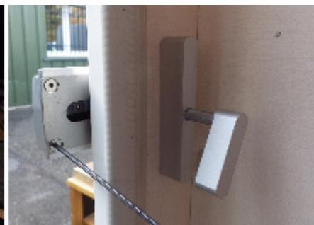
17 - Hebel anbringen und blockieren (nach unten=geschlossen), dann Edelstahlplatte und die 2 Fräskopfschrauben M4 anbringen
